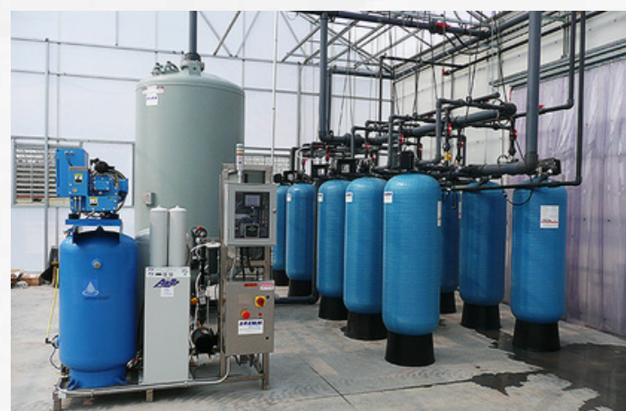
Производство монтажных и пуско-наладочных работ систем водоподготовки
