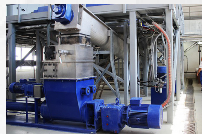
Производство монтажных и пуско-наладочных работ систем очистных сооружений
