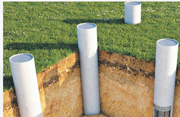
Бурение скважин под свайные основания
