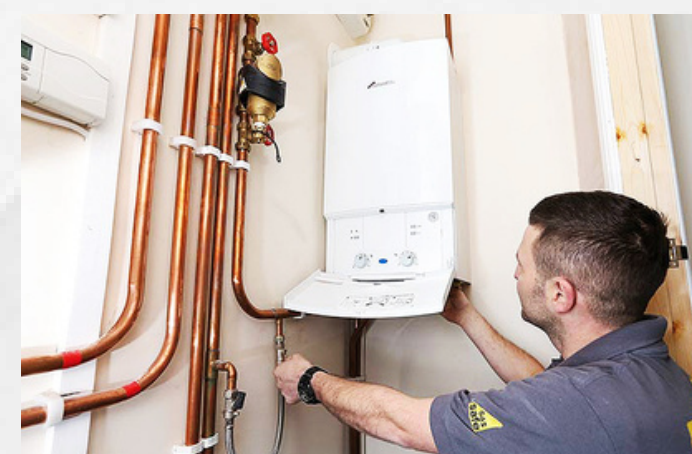
Производство монтажных и пуско-наладочных работ отопительных систем
